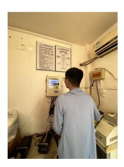
③ 支援人员赶至废水站总排口及 2#废水站现场采样分析,经采样分析得知为总排口出水水质正常,2#废水站 pH 调整池水质异常,初步判断为 pH 调整池探头故障;
